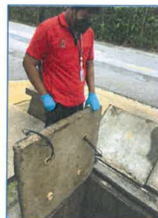
บ่อตรวจคุณภาพน้ำหลังผ่านระบบบำบัด
